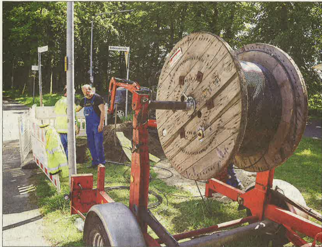
Von großen Kabeltrommeln werden die Glasfaserkabel abgerollt und durch Leerleitungen, die bereits im Erdreich verlegt wurden, mit Luftdruck geschossen. –
