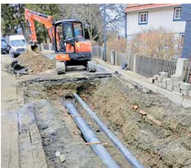
Per Bagger ließen die Stadtwerke die unter der Straße verlaufende Transportleitung im Bereich des Risses freilegen.
