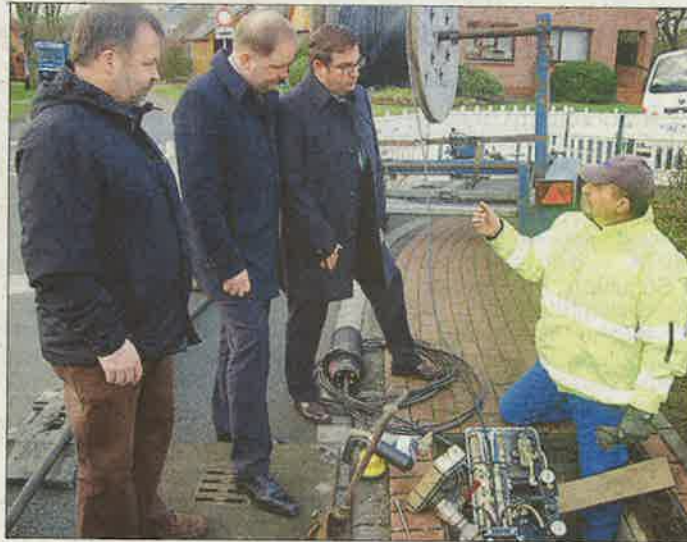
Dirk Pettersson von K+R Eilers (r.) zeigt (v.l.) Andreas Dumstorff, Johann Wimberg und Frank Wölbern, wie die Glasfaserkabel durch die Leerrohre geführt werden. BILD: CARSTEN BICKSCHLAG
