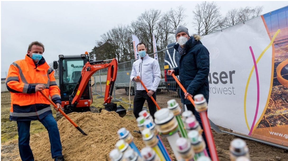
René Winter (Geschäftsführer des Bauunternehmens K & R Eilers GmbH), Oliver Prostack und Rüdiger Mittmann (von links) greifen zum Beginn des Netzausbaus symbolisch zum Spaten. Foto: André Thöle/Gemeinde Wallenhorst
