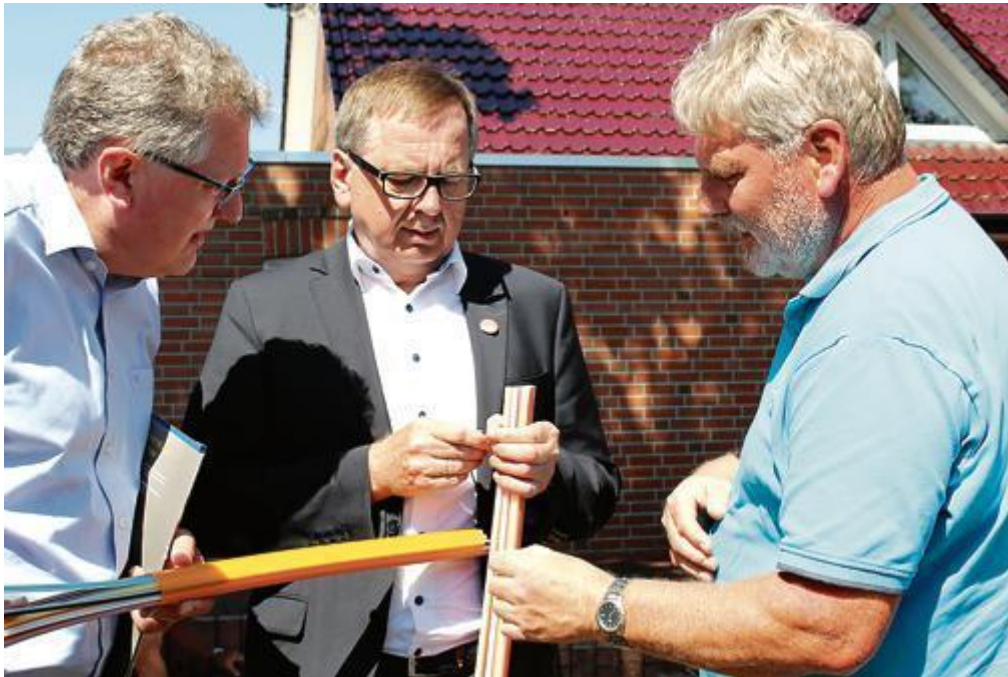
Geld Niemann (EWE Netz) und Bauleiter Anton Fürup erklärten Bürgermeister Dr. Wolfgang Wiese den FTTH-Ausbau.
